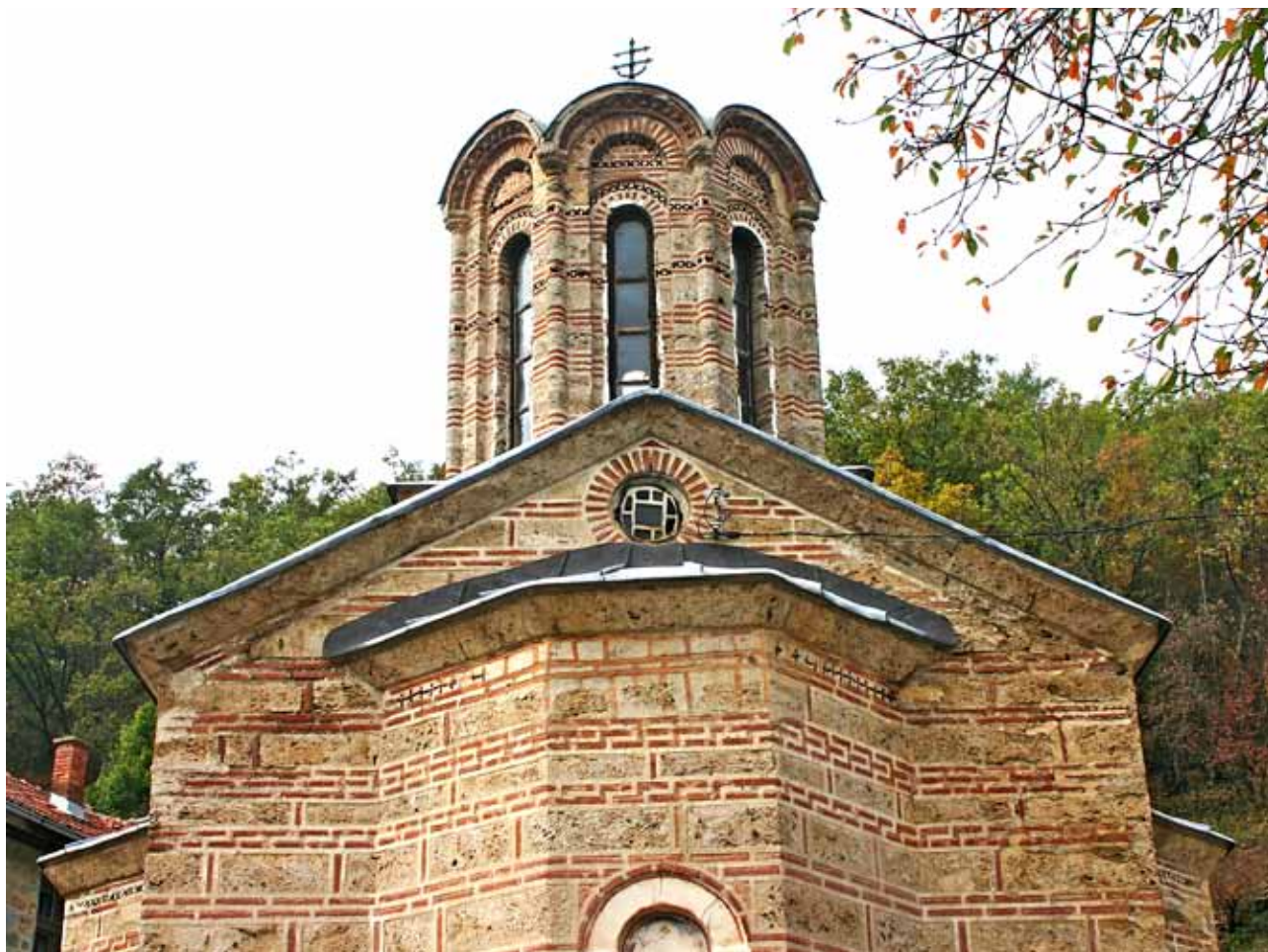
Сл. 16 Црква Светих арханђела, поглед са истока
